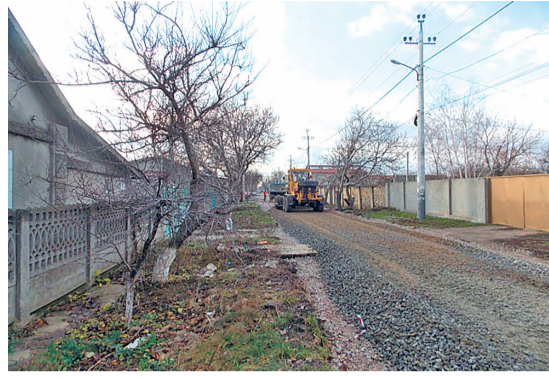
Капитальный ремонт ул. Патриотическая
