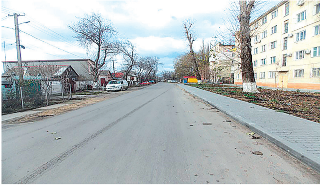
Капитальный ремонт ул. Болградская
