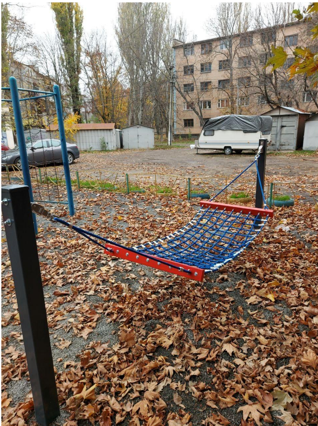
5) Капітальний ремонт елементів благоустрою території в районі житлового будинку за адресою: м. Одеса, Люстдорфська дор., 29-А
